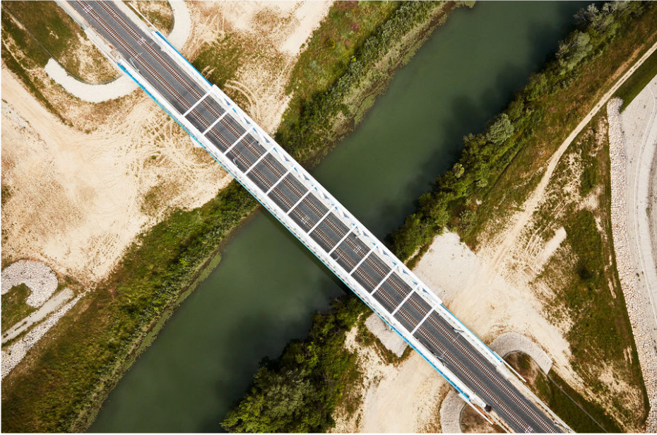
◀ Viaduc du Vidourle, Gallargues-le-Montreux (30)
